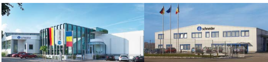
Fábrica 1 en Nordheim fábrica 2 en Nordheim | Fábrica en Rumanía
