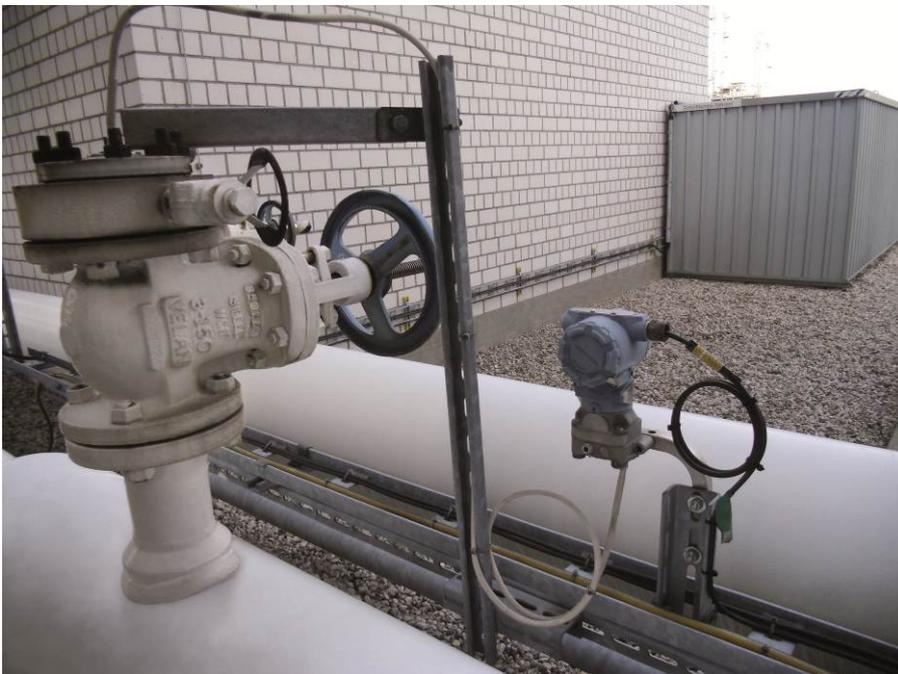
**Bild 3 und 4:** Montagebeispiel: Der Ring wird mit einer Flanschverbindung zwischen dem Absperrventil und dem Messgerät angebracht.
