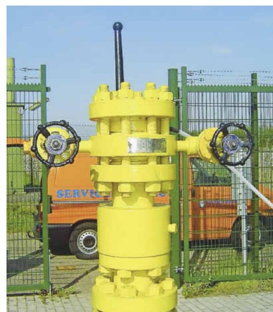
*Der Ring wird mit einer Flanschverbindung zwischen dem Absperrventil und dem Messgerät angebracht*
